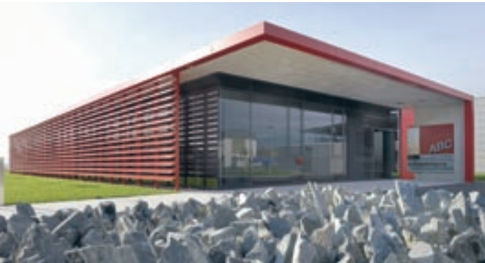
Standort Wolfsberg | Wolfsberg location
